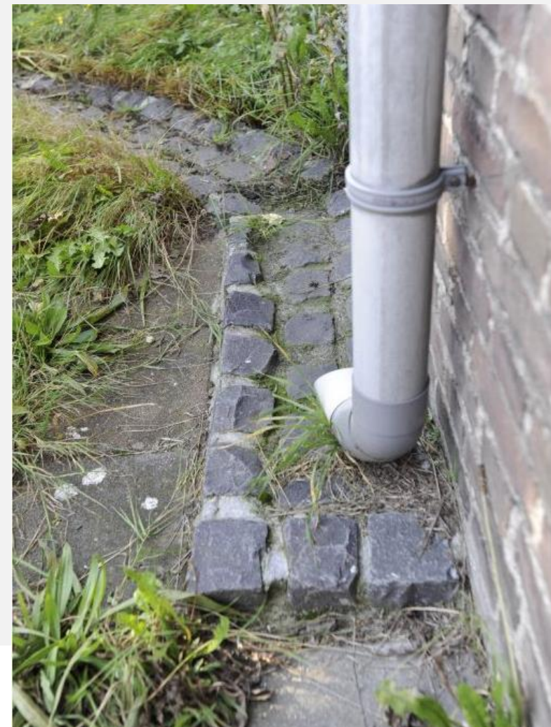
Figuur 1 Door het regenwater op een natuurlijke manier te laten infiltreren in de bodem, verlichten we de druk op het rioleringssysteem. Bron: GAW | Stichting RIONED
