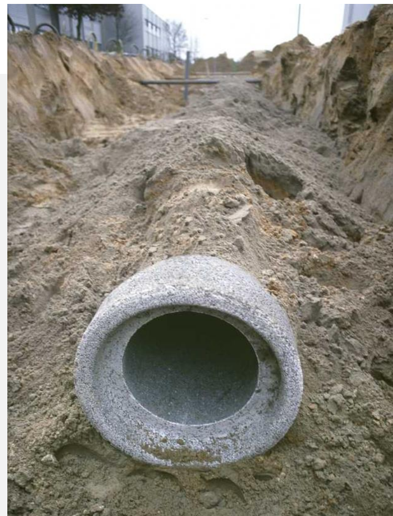
Figuur 2 De aanleg van een rioleringsstelsel heeft veel voeten in de aarde. Bron: GAW | Stichting RIONED
